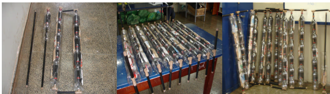
Figura 11: Processo de montagem das colunas do ASBC
